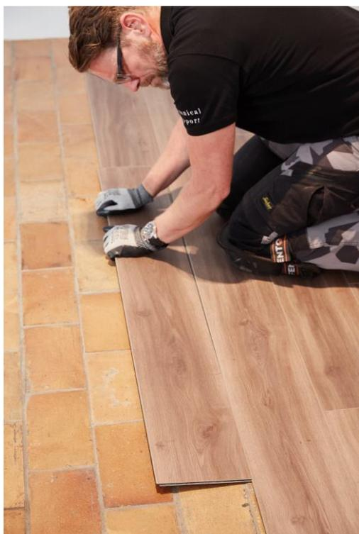
Zum Einfügen der letzten Plankenreihe müssen die Planken in der Regel zugeschnitten werden. Legen Sie dazu eine Planke deckungsgleich auf die vorletzte Reihe, legen Sie eine weitere Planke obenauf und positionieren Sie diese mit der Außenseite direkt zur Wand. Zeichnen Sie ihre Vorderkante auf der Diele darunter ein. Berücksichtigen Sie dabei den einzuhaltenden Randabstand. Jetzt können Sie diese Planke
