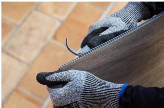
Legen Sie die Planke mit den abgeschnittenen Seite an die Wand an. Verwenden Sie die Abstandhalter zum Einhalten des umlaufenden Randabstands, als stabiles Gegenlager um ausreichend Druck beim Einrasten einwirken zu lassen und um die Unebenheiten der Wand auszugleichen. Für einen absolut geradlinigen Verlauf der Plankenreihen ist zu sorgen.
